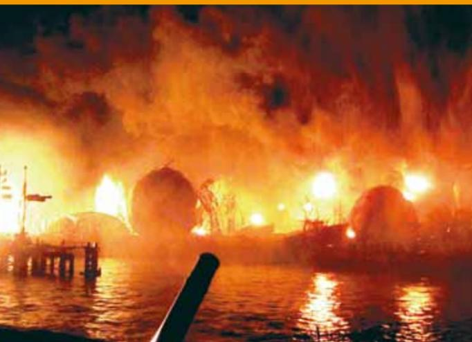
激しく炎を上げて燃え続けた千葉県市原市にある精油所のLPガスタンク。地震によりガスタンクが落下、下にあったガス管が破裂して爆発炎上した。
