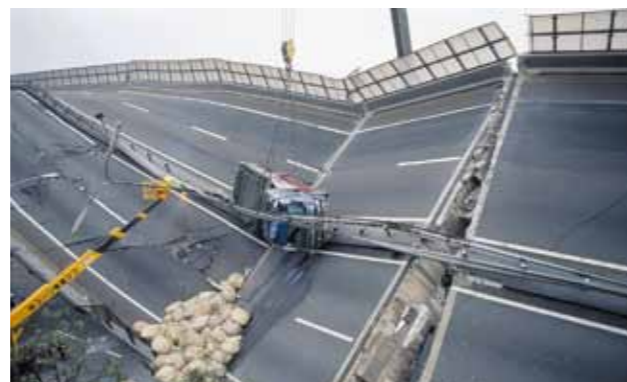
倒壊した高速道路[平成7年(1995) 阪神・淡路大震災]
