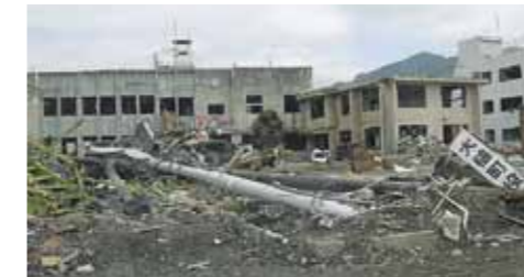
倒壊した岩手県大槌町役場
