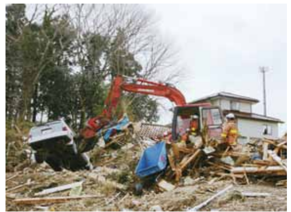
特殊重機による、がれきの撤去作業
