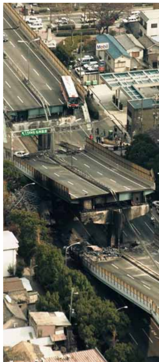
崩壊した阪神高速道路
