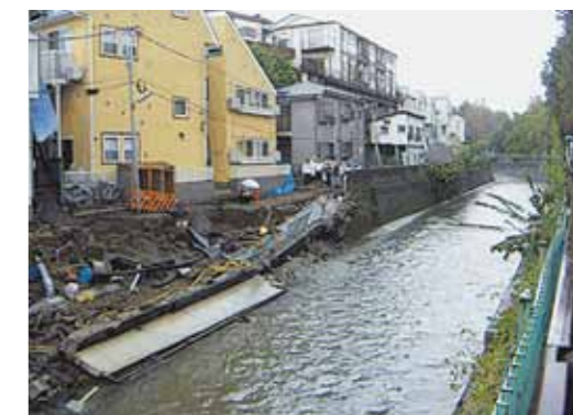
妙正寺川の被災状況(中野区)[平成17年(2005)9月]
