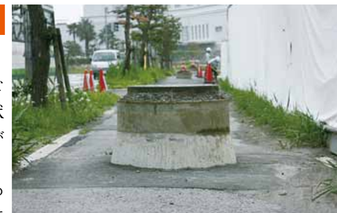
液状化の影響を受けたマンホール(千葉県浦安市)[平成23年(2011) 東日本大震災]
