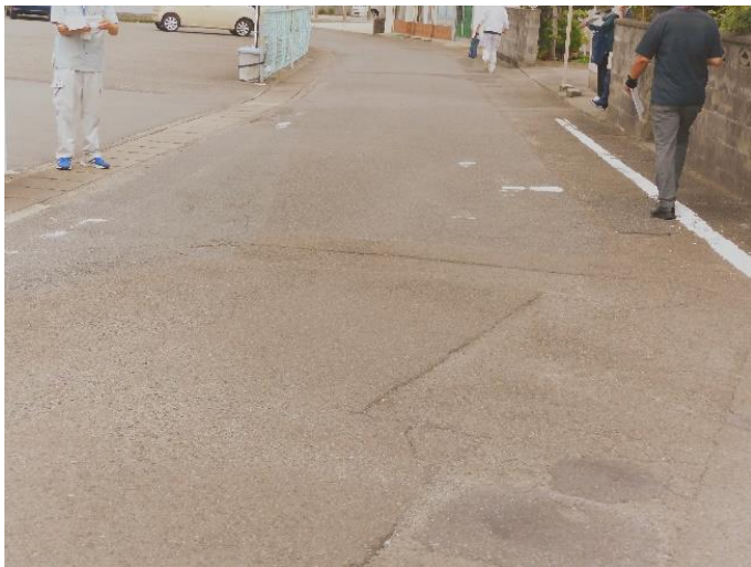
危険箇所の点検
