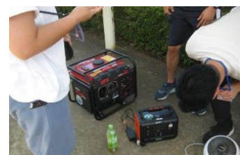
発電機の確認
