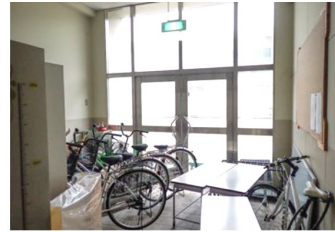
昇降口〈避難の支障〉
