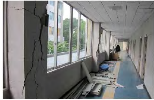
＜校舎内の柱に亀裂＞
