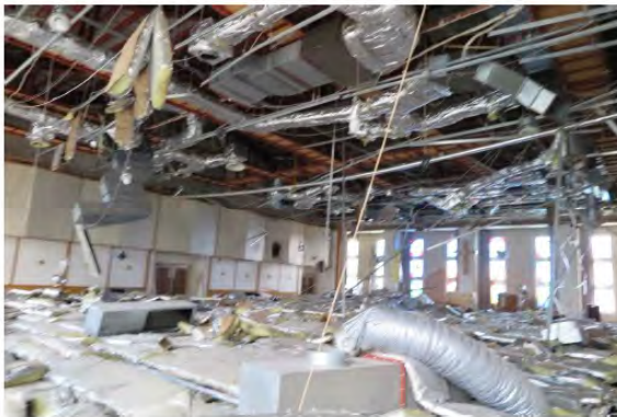
＜最上階ホール天井の脱落＞
