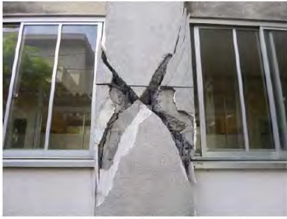
＜柱のせん断破壊＞
