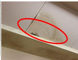
天井材のしみ、破損
