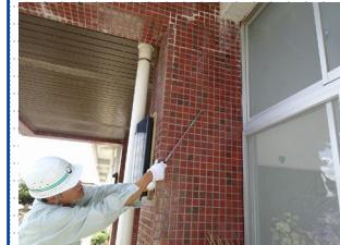
12条点検実施状況 タイルの打音検査
