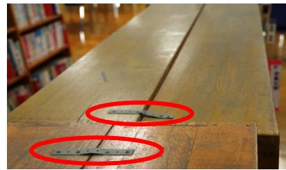
写真1. 棚同士の連結による固定の例
