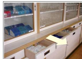
写真2. 震動により開いた引き出しの例
