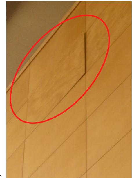
写真6. 内壁のずれ
