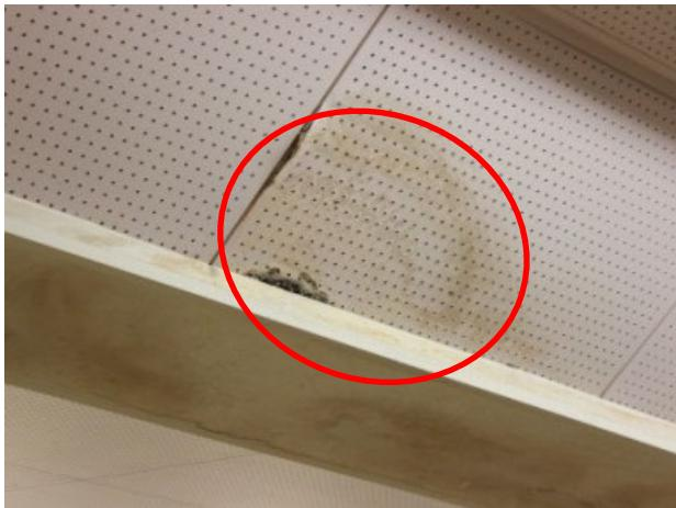
写真1. 天井材のしみ、破損
