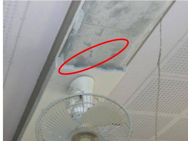
写真4. 梁のモルタルの脱落
