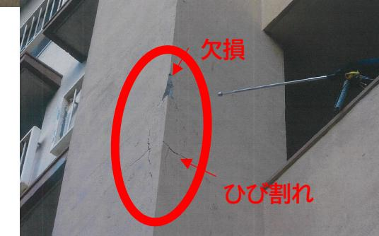
写真2. コーナー部のひび割れ、欠損
