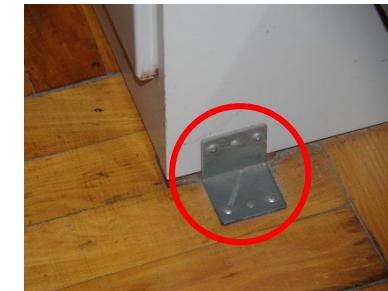
写真2. 棚の下部を床に固定した例
