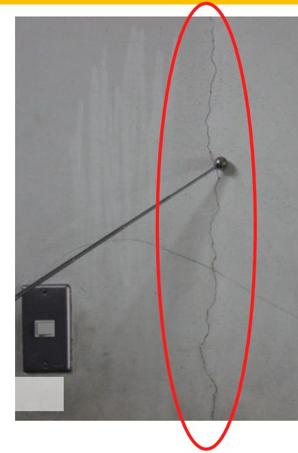
写真5. 内壁のひび割れ
