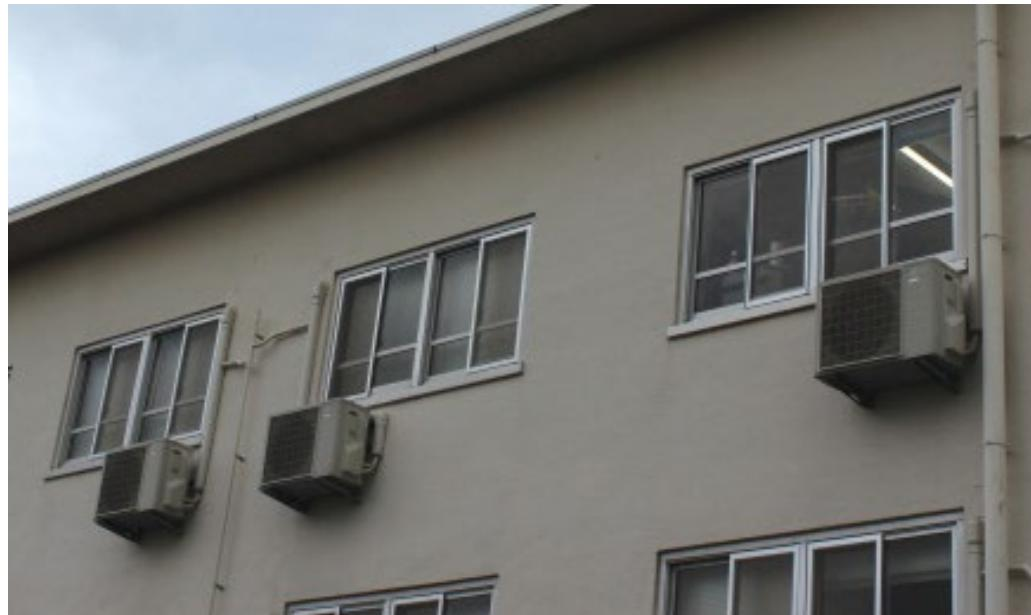
写真1. 壁面に設置された室外機
