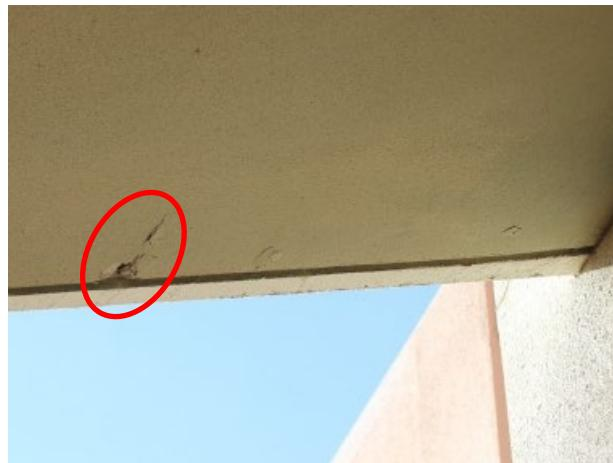
写真2. 階段裏のひび割れ
