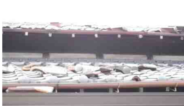
【岩槻区 自治会館屋根 岩槻区役所コミュニティ課より提供】
