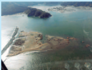
震災後、津波と地盤沈下による浸水被害
