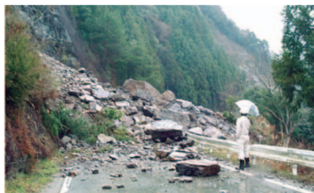
芸予地震による高知県土佐郡土佐町井尻のがけ崩れ
