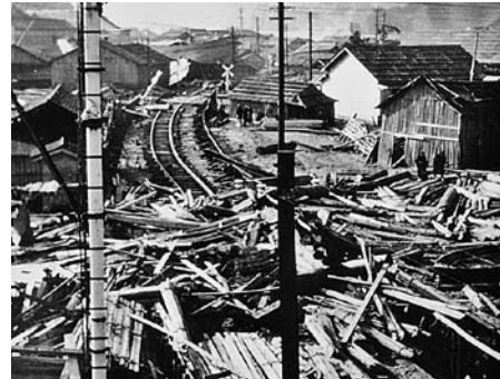
線路を津波による漂流物がふさぐ（須崎市浜町付近） 提供：須崎市
