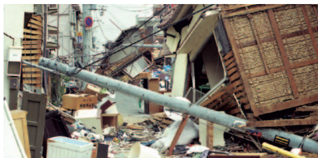
地震で倒壊した家屋（提供：高知新聞社）
