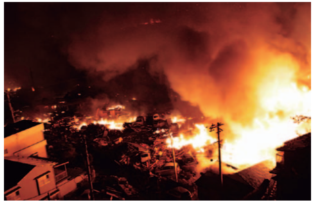
岩手県山田町の津波火災(平成23年3月12日/提供:山田町)
