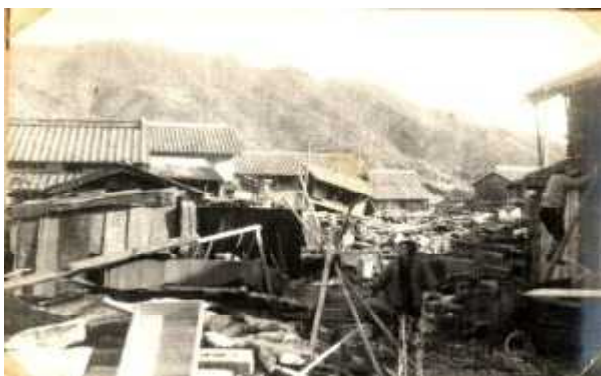
○牟岐町東部の被害，津波の通った道筋
