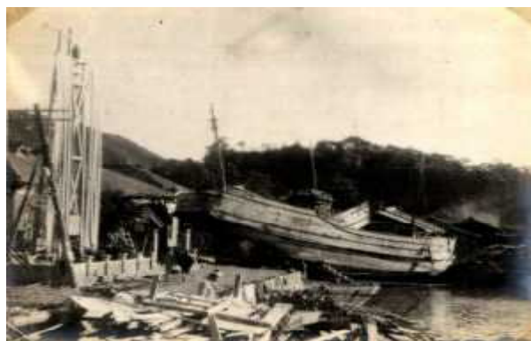
○牟岐町，道路に押し上げられた漁船
