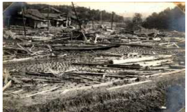
○牟岐町，田園の被害
