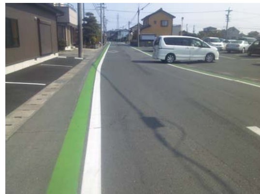
事業③：整備後の通学路
