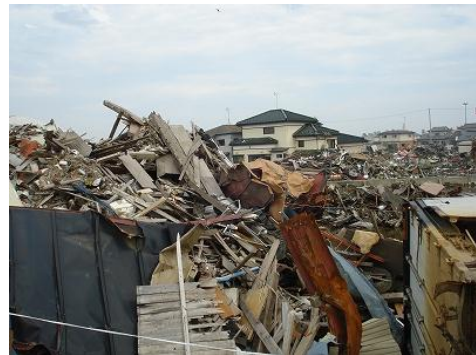
壊滅した東松島市大曲浜
