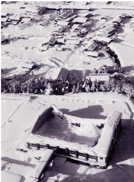
屋根が崩壊した郡上北高校(56 豪雪)
