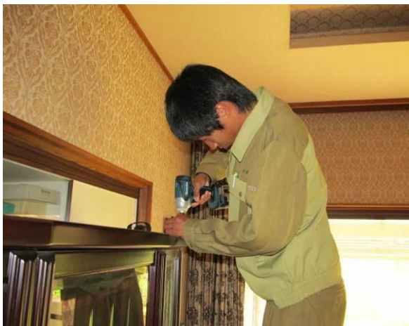
L型金具の取付け
