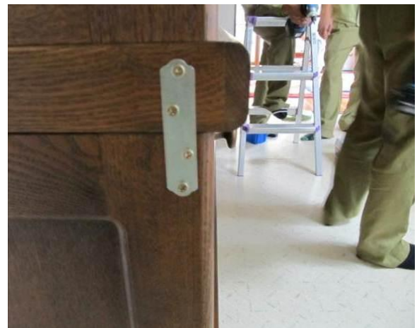
上部、下部の連結施工例
