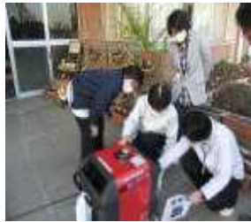
発電機操作訓練
