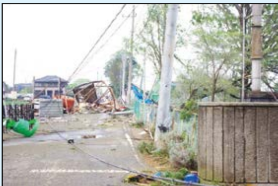
正門付近の被害状況
