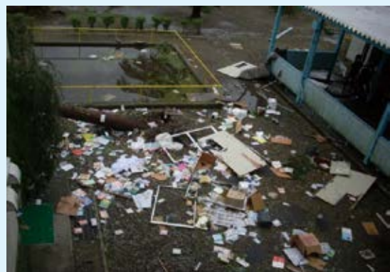
裏庭に散乱した窓枠、扉、書類等
