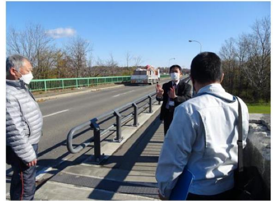
【合同点検の様子】
