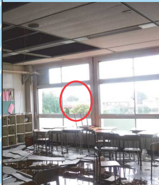
飛来物による窓ガラス破損
