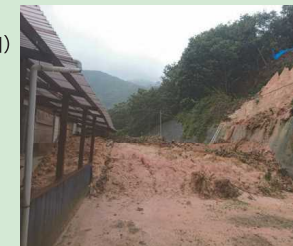
斜面（斜面）の崩壊による被害
