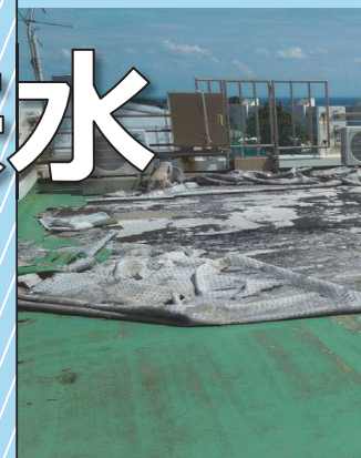
屋上防水が剥がれ室内が水浸し
