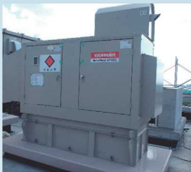
非常用発電機を屋上に設置
