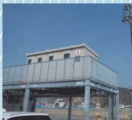
屋外キュービクルのかさ上げ
