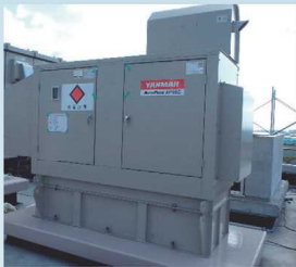
非常用発電機を屋上に設置
