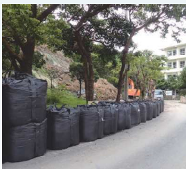
土のうによる応急対策
