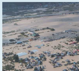
洪水による被害
