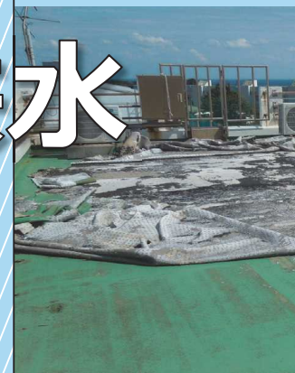
屋上防水が剥がれ室内が水浸し
