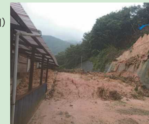
法面（斜面）の崩壊による被害
