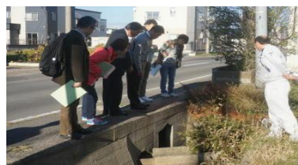
五所川原市合同点検の様子
