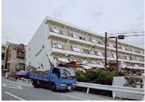
集合住宅の倒壊(平成7年(1995年)兵庫県南部地震) (西宮市提供)
