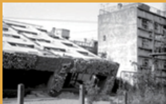
液状化による建物の転倒 (昭和39年(1964年)の新潟地震) (戸田建設株式会社提供)
