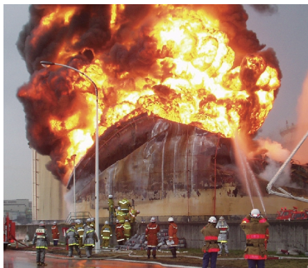
苫小牧での石油タンクの火災(総務省消防庁提供)
