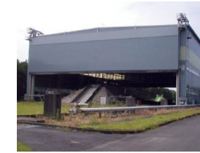
大型降雨実験施設の外観
