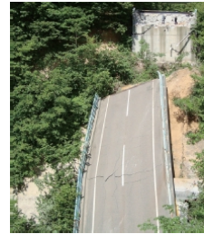
岩手・宮城内陸地震時の 大規模な斜面崩壊の 影響により落橋した祭師大橋 (岩手県南広域振興高一開総合支局提供)
