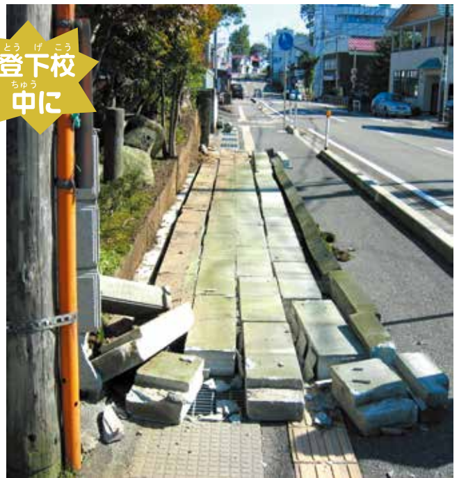
▲地震で倒れたブロック塀 ：新潟県中越地震／平成16年（2004年） * 写真提供：東北大学
