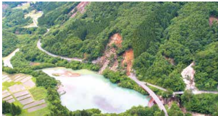
▲山崩れ：岩手・宮城内陸地震／平成20年(2008年) *写真提供：岩手県
