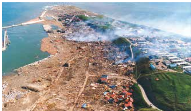
▲津波と地震後に発生した火災による被害 (写真手前の土のところで街並みがありました。) :北海道南西沖地震/平成5年(1993年) *写真提供: 阿部勝征氏
