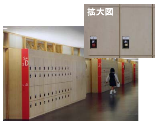
突起が無いように配慮されたロッカー (各個人が南京錠を持参して使用する。 窪んだ部分に鍵を取り付ける)
