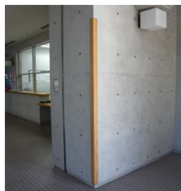
衝突時の被害が小さくなるよう工夫された壁
