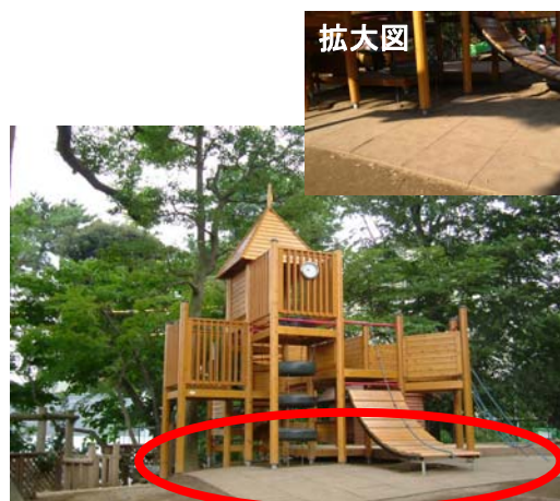
転落時の衝撃を少なくするため、 地面に緩衝材が設けられた遊具
