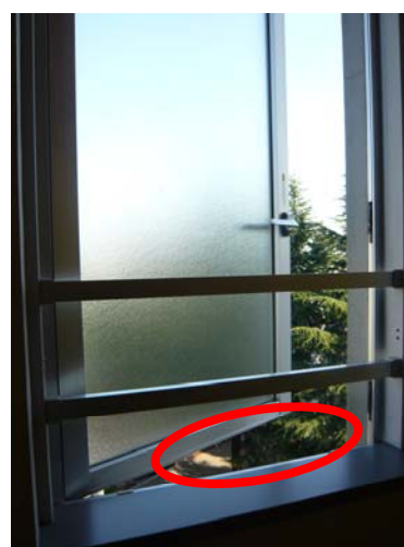
開口幅が制限された片開き窓 開くときに、身を乗り出して 転落しないよう手すりも設置 (二重に配慮されている)
