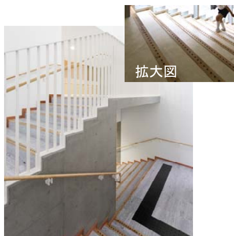
段鼻が判別しやすいように工夫された階段
