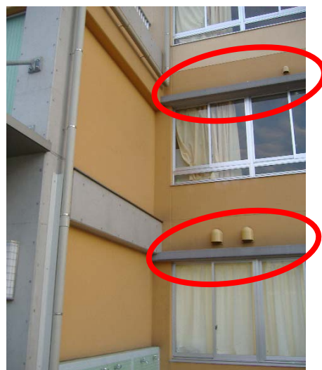
上階窓からの距離があり、幅が狭く降りられないような雨よけの庇
