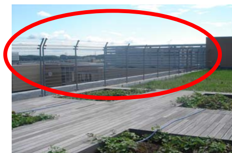
フェンスで囲むことで安全対策がとられた屋上
