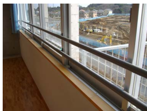
窓に設置された手すり
