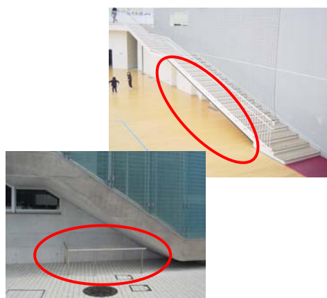
衝突に配慮した階段下
