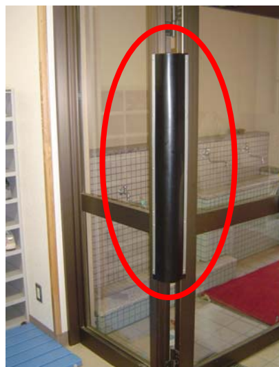
蝶番側の隙間に指を挟まれないように覆いが設置された開き戸
