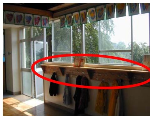
掛け具に衝突することがないように、覆いを設けた壁
