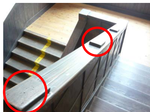
滑り降りることができないように突起を設けた側壁
