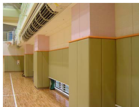
緩衝材を設置し、衝突に配慮した屋内運動場の柱
