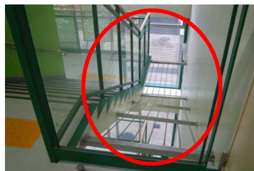
下まで転落しないよう吹抜けに格子を設けた階段
