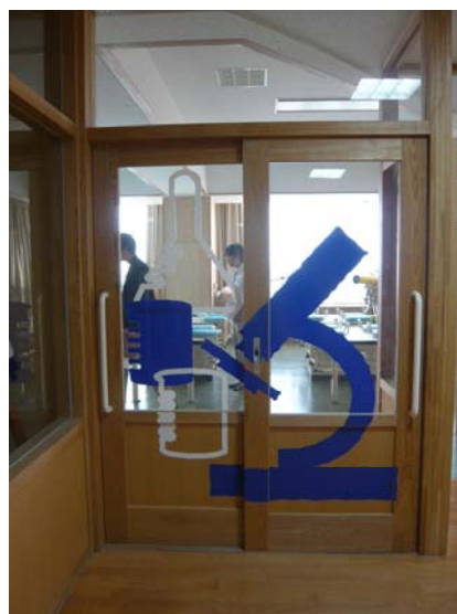
錯覚して衝突しないよう 工夫された開口部
