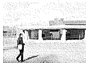
石巻市立大川小学校校舎跡
