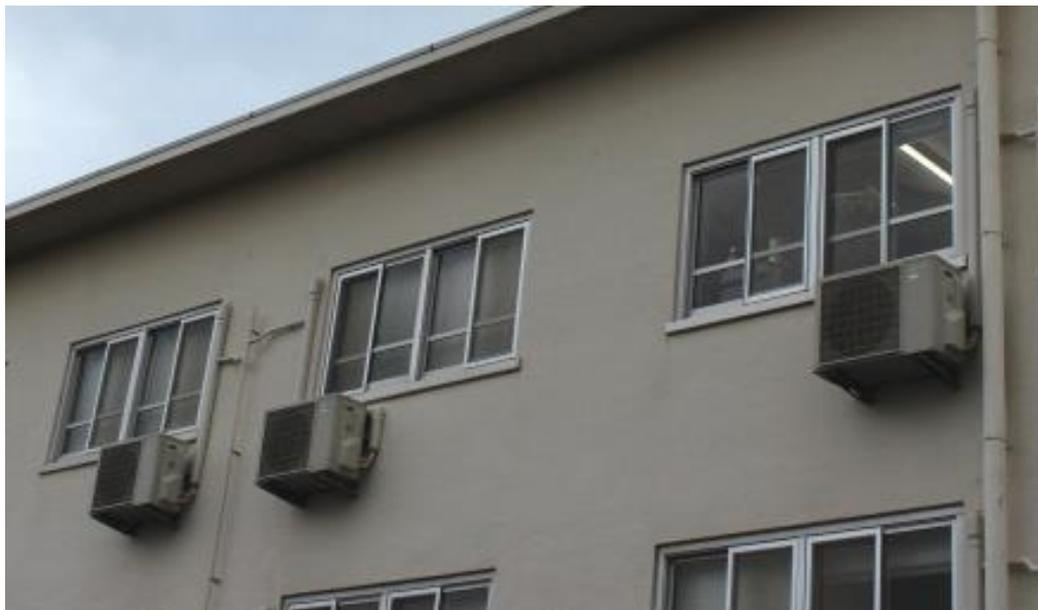
写真1. 壁面に設置された室外機
