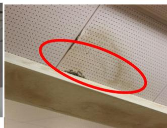
天井材のしみ、破損
