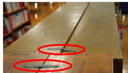
写真1. 棚同士の連結による固定の例
