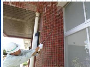
12条点検実施状況 タイルの打音検査
