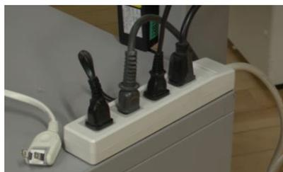
←コンセントの使用制限を超えて電気製品を接続しないようにする
