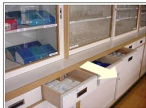
写真2. 震動により開いた引き出しの例
