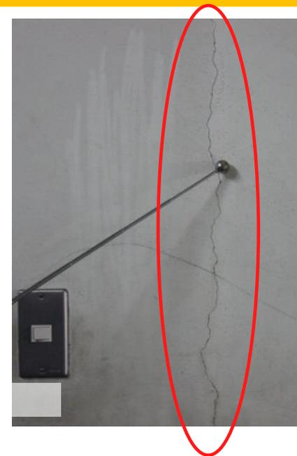
写真5. 内壁のひび割れ
