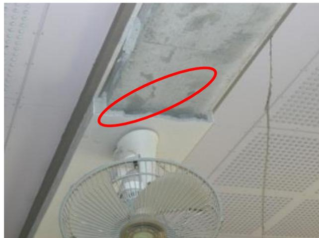
写真4. 梁のモルタルの脱落
