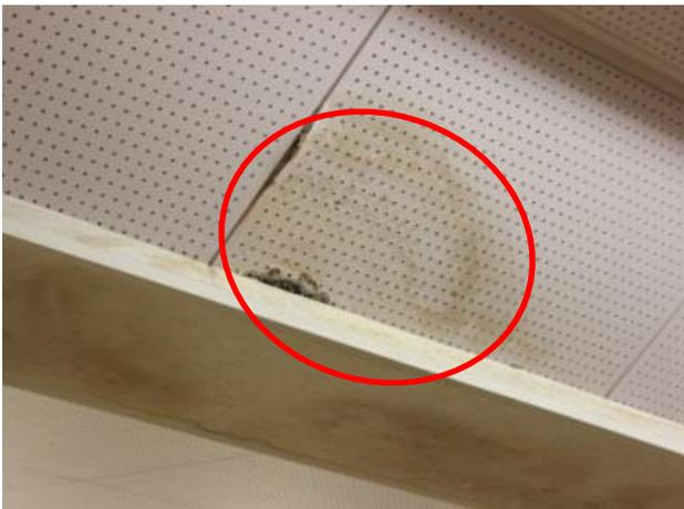
写真1. 天井材のしみ、破損
