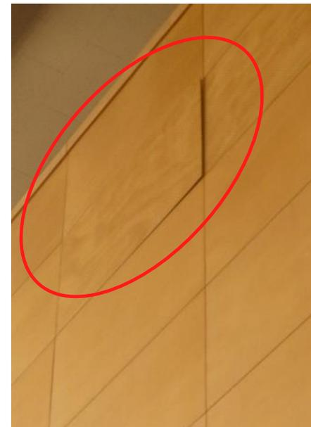
写真6. 内壁のずれ
