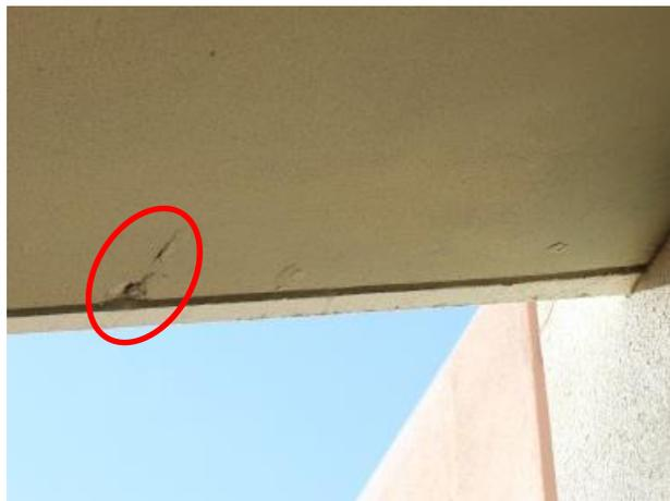
写真2. 階段裏のひび割れ
