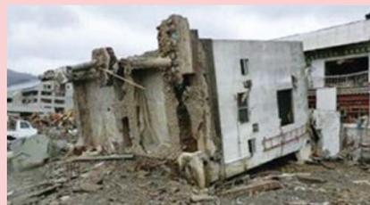
津波で倒壊したコンクリートの建物（女川町）
