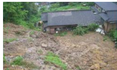
大雨によるがけくずれ（長崎県南島原市） 写真提供（国土交通省）
