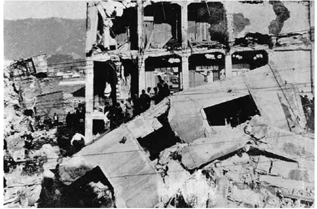
ビルの倒壊 高知市堺町付近
