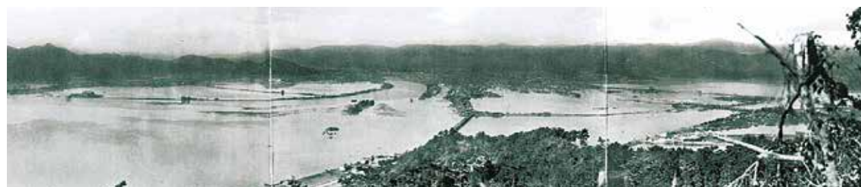
昭和南海地震の後 (地盤沈下が1.15m)
