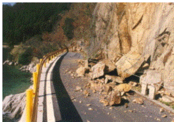
平成13年芸予地震による崖崩れ（周防大島町）
