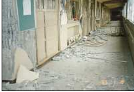
阪神・淡路大震災時の被害状況
