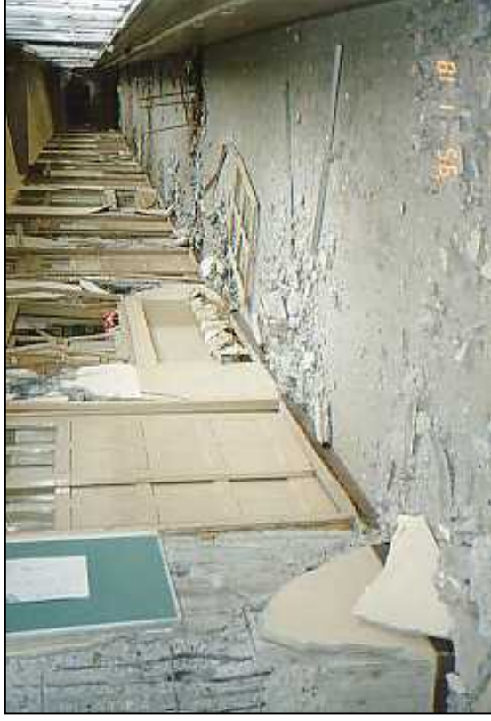
阪神・淡路大震災時の被害状況
