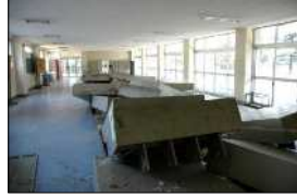
東日本大震災時の被害状況
