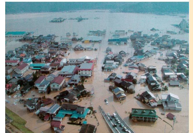
円山川の氾濫により浸水した住宅街（豊岡市江本） （写真提供 近代消防社）
