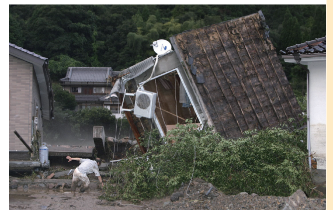
洪水により倒れた家屋（佐用郡佐用町）（写真提供 神戸新聞社）
