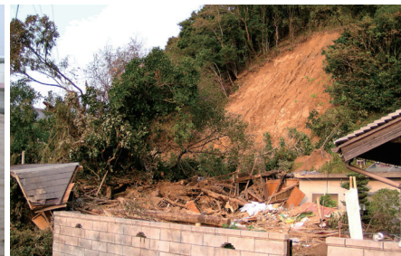
土砂災害により家屋倒壊 （淡路市 2004〔平成 16〕年台風第 23 号）
