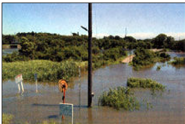
台風(6号)による豪雨(平成14年7月)
